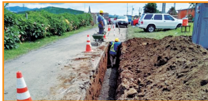
Zanja para colocación tubería redes secundarias en Coronado.
