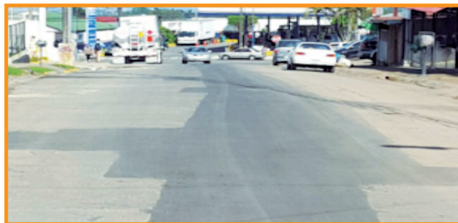
Obra concluida en Vazquez de Coronado, 2016.
