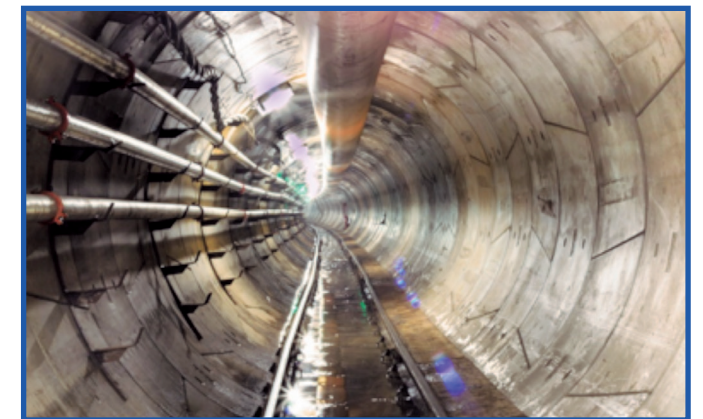
Imagen interna del túnel enero 2016
